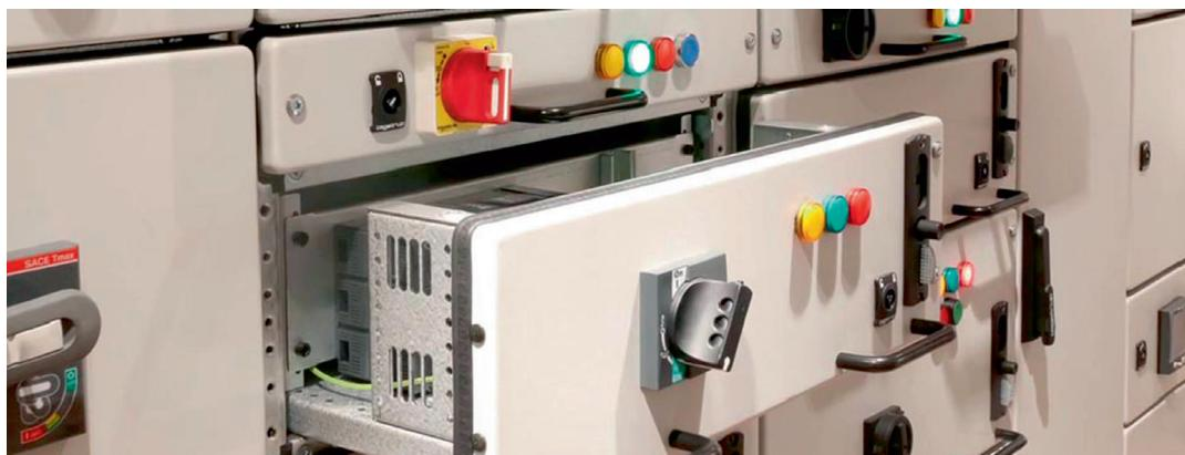
Для отходящих линий может быть предусмотрена система автоматического повторного включения электродвигателей, подключенных к НКУ. Данная система предназначена для обеспечения повторного запуска электродвигателей, отключенных в результате кратковременного исчезновения или снижения напряжения на сборных шинах НКУ.
